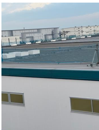
2026年12月着工太陽光リプレース工事中
